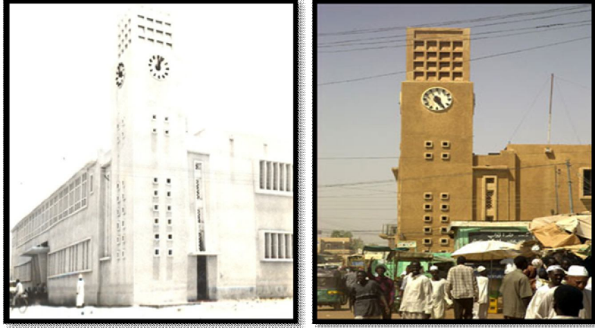
شكل (٦٧-٨) مبنى محلية أمدرمان-المصدر: المخطط الهيكلي الخامس لولاية الخرطوم، ٢٠١٢م
