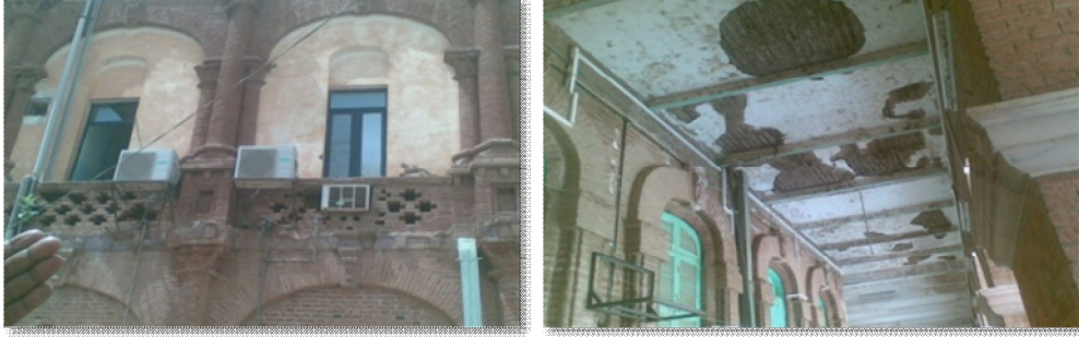
نوافذ الألمونيوم وتركيب المكيفات العشوائي واحتواء البرندات تفقر البياض نتيجة الترميم العشوائي
